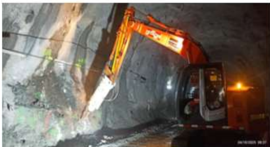
Túnel Santa Elena 2 – Exc Nichos
