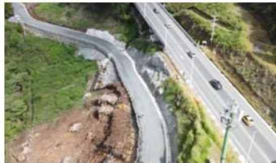
Construcción Vía Industrial (1500 m): 100%
