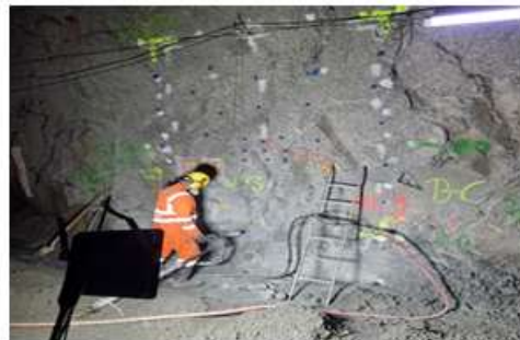
Túnel Santa Elena 2 – Exc Nichos
